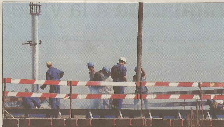
Trabajadores de la construcción en la obra de un edificio. // FDV
